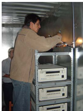
Instalación de los equipos en Cusco
