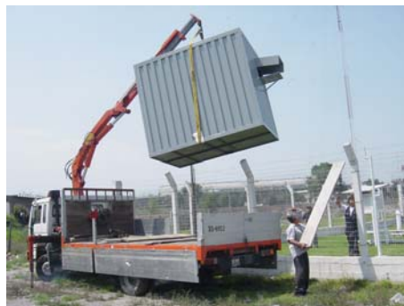
Instalación de la caseta en Arequipa
