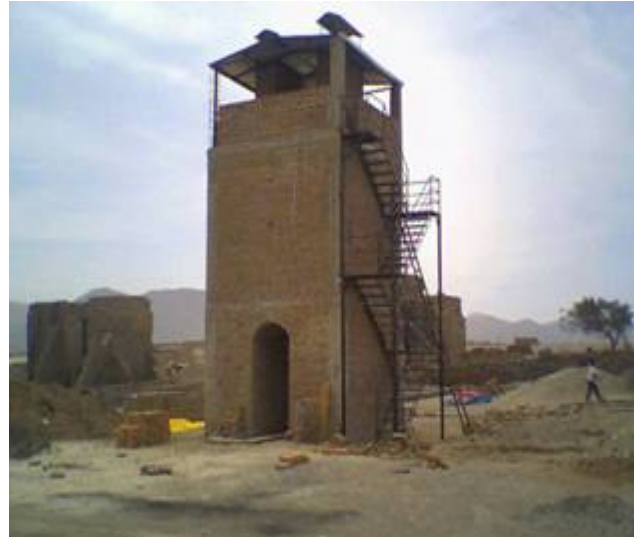
Horno de ladrilleras en la ciudad de Arequipa
