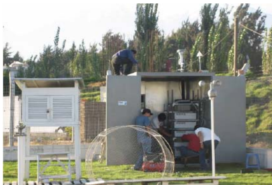
Actividades de mantenimiento en la estación de monitoreo en Arequipa
