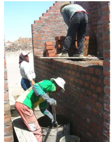
Construcción del horno piloto
